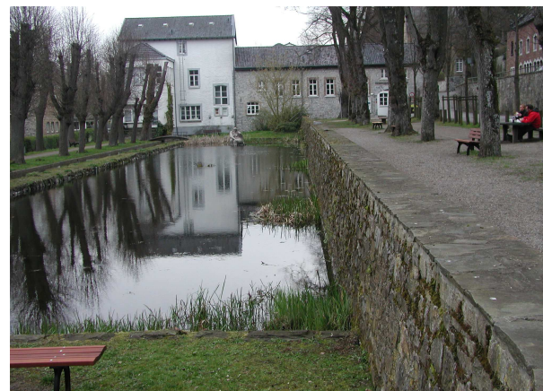
Sollzustand nach Reinigung
